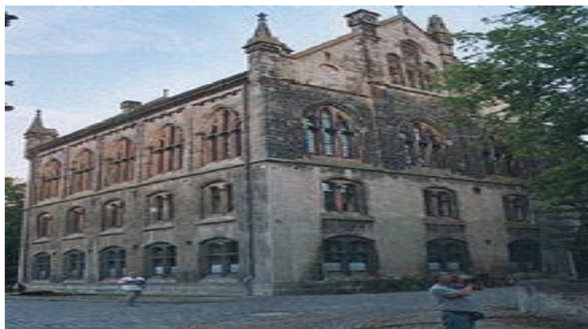
Imagem 3 – Pforta, Altes Schulhaus
