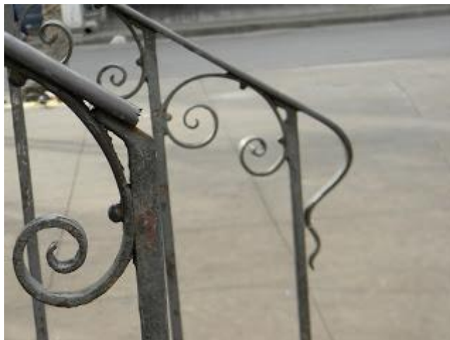
Figura 14: Corrimão que dá acesso ao coreto.
