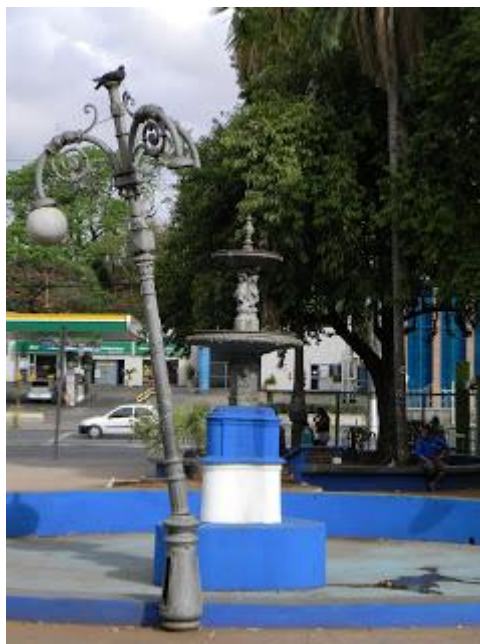
Figura 08: Poste envergando devido ao mau uso e falta de manutenção.
